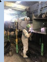
溶接作業の様子
