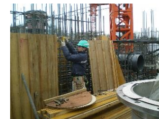
【コンクリートを流し込むための型枠を組む作業の様子】
